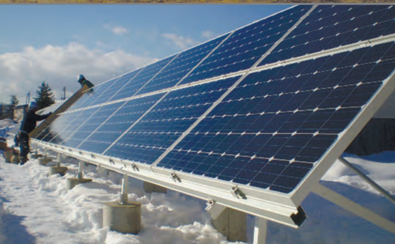
30cm~200cmの積雪に対応する極太の骨組みを使用した架台
