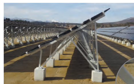
積雪に対して最も理想的なW型トラス構造を採用。地盤高は1m以上。
