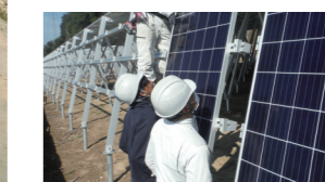
前面に防風板を兼ねた パネルを設置
